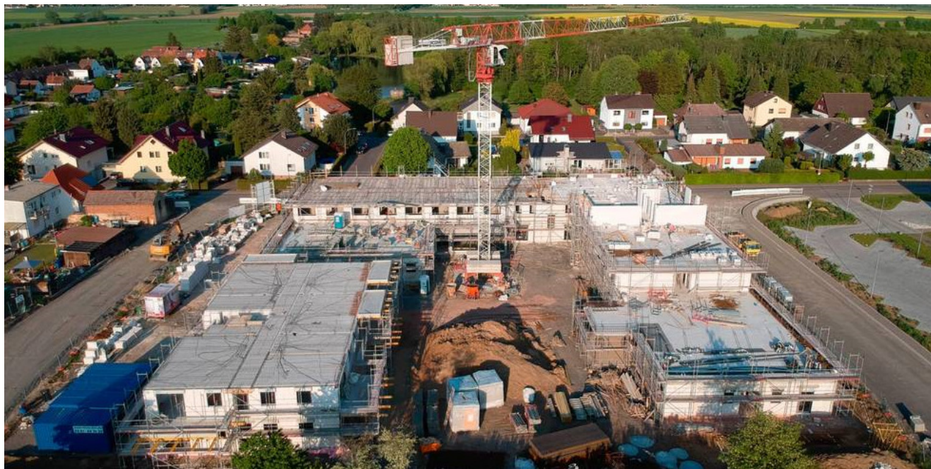
Aktuell herrschen noch die Bauarbeiter über das Pflegezentrum "Am Heiligen Stein" in Weckesheim. Foto: Depant
